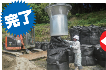
④「瞬作」を抜いて作業完了
